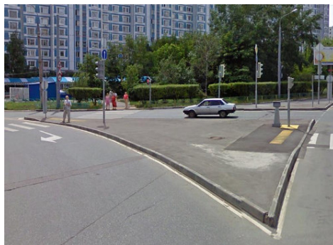
Рис. 11 – Канализирование движения на перекрестке
