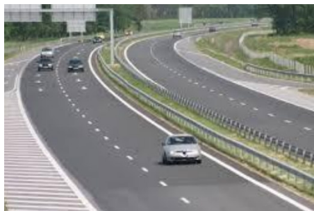
Рис. 10 – Канализирование движения на автомагистрали
