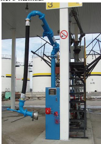
Рис. 5 – Комплекс нижнего налива
