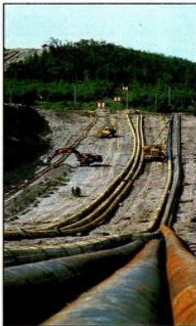
Рис. 1.4 – Магистральный трубопровод
