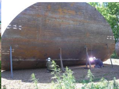
Рис. 2 – Монтаж днищ: а) разверткой; б) укладкой
