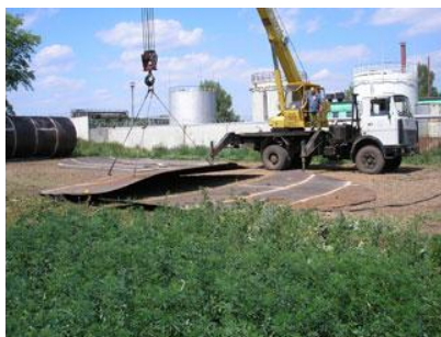
Рис. 2 – Монтаж днищ: а) разверткой; б) укладкой
