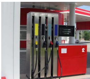
Рис. 3 – Топливораздаточные колонки (ТРК) предназначены для заправки автомобилей топливом, а так же измерения и учета налитого топлива.
