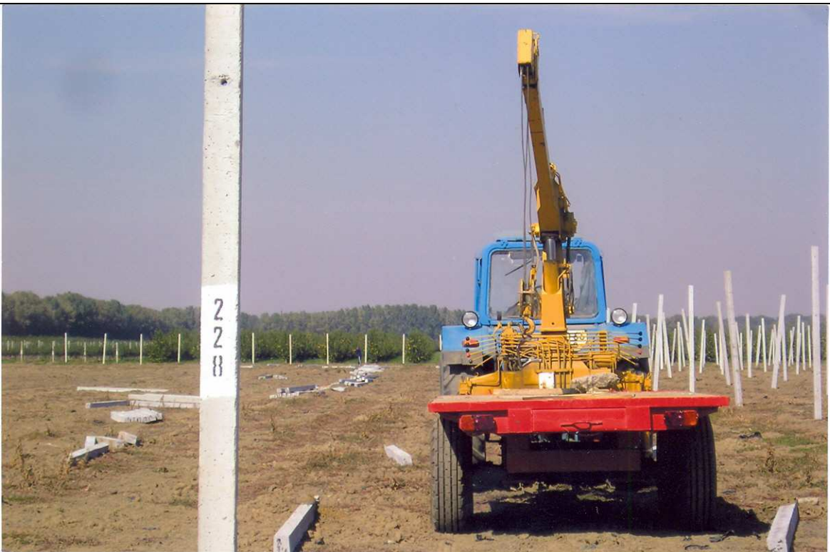
Рисунок 13. Выгрузка и установка железобетонных столбов для плодового сада
